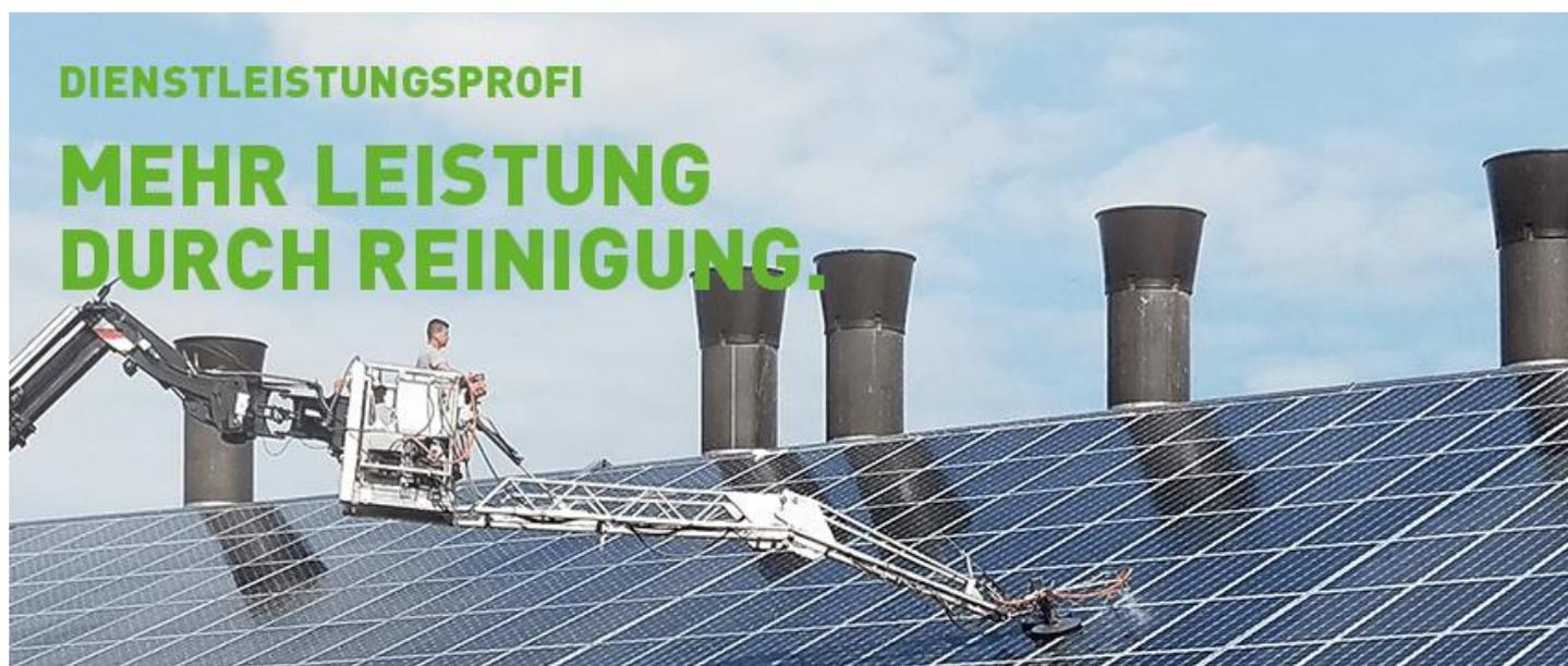
Damit Photovoltaikanlagen optimale Erträge erzielen können, bedarf es oftmals einer gründlichen maschinellen Reinigung. Durch Umwelteinflüsse wie z.B. Moos, Dachflechten, Staub, Pollen, Insekten, Vogelkot oder Ruß von Kaminen oder Heizungsanlagen kann eine Photovoltaikanlage verschmutzen. Die oftmals geringen Niederschläge in den Sommermonaten reduzieren zusätzlich den Selbstreinigungseffekt der Moduloberflächen. Dadurch kann es zu einer verminderten Leistungsfähigkeit und Stromerzeugung kommen.
